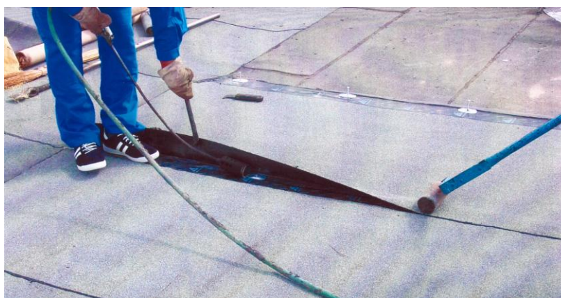
Рис. 5. Сплошная наклейка газовой горелкой рулонного материала (а) и проклейка швов (нахлёсток) при механическом креплении нижнего слоя ковра (б).
